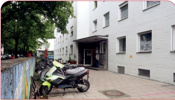
Städtisches Übergangwohnheim Johannes-Rösle-Straße 10
